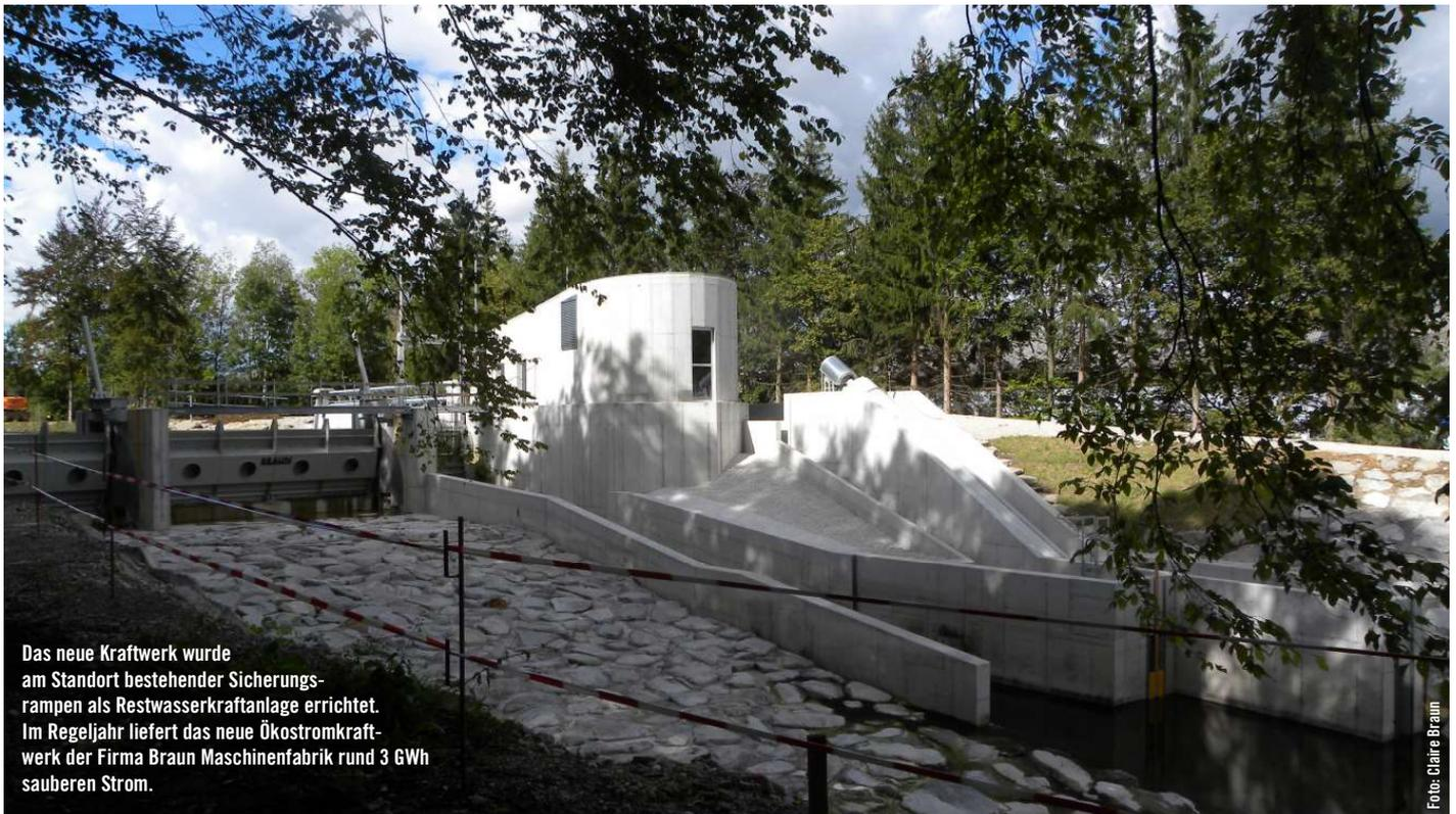
Das neue Kraftwerk wurde am Standort bestehender Sicherungsrampen als Restwasserkraftanlage errichtet. Im Regeljahr liefert das neue Ökostromkraftwerk der Firma Braun Maschinenfabrik rund 3 GWh sauberen Strom.
