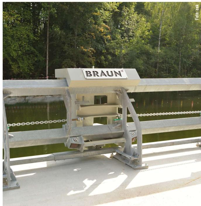
Dass das eigene Kraftwerk eines Betreibers, der zu den renommiertesten Branchenspezialisten im Stahlwasserbau zählt, auch Innovatives aufweist, versteht sich fast von selbst. Neuartig ist die installierte Horizontalrechenreinigungsmaschine (re) insofern, als Braun erstmalig dabei ein Antriebskonzept ohne Zahnstangen und Antriebsräder umsetzte. Dadurch ist diese Maschine nicht nur äußerst betriebssicher und extrem wartungsfreundlich, sondern darüber hinaus auch noch sehr leise und laufruhig.
