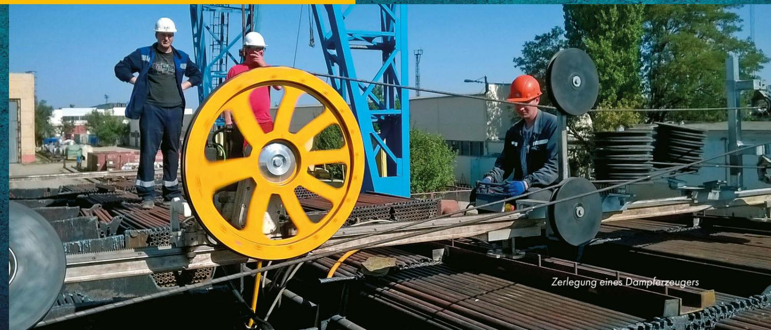
Zerlegung eines Dampferzeugers
