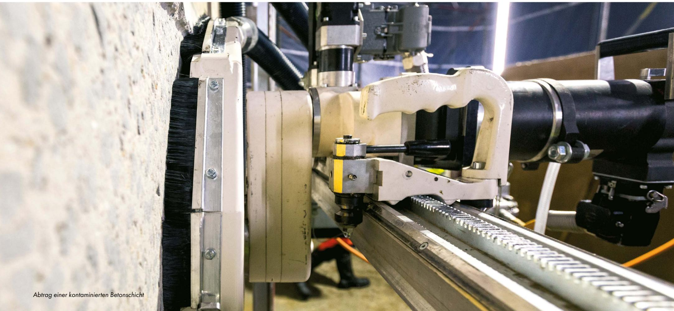
Abtrag einer kontaminierten Betonschicht
